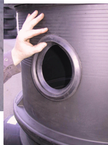
Postavljanje ulazne brtve
