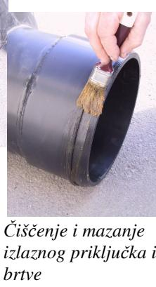
Čišćenje i mazanje izlaznog priključka i brtve
