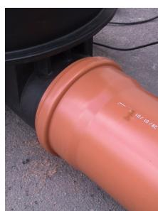
Pravilno izveden PVC izlazni priključak
