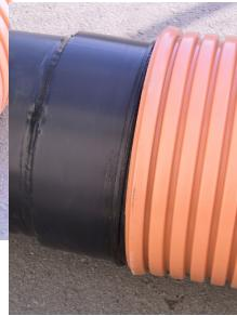
Spajanje izlaznog priključka i PVC rebraste cijevi
