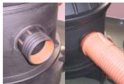
Izvedba dodatnog priključka za rebraste cijevi
